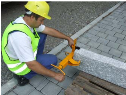
Stele/Palisade wird liegend eingespannt und gegriffen
