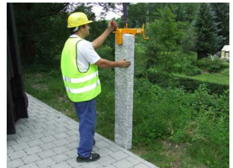
Stelen/Palisaden werden dicht an dicht versetzt. Mit der Handkurbel wird der Stelensetzer gelöst.
