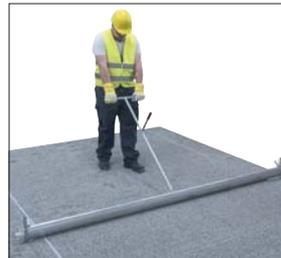
FIXPLAN FP Système de nivellement manuel
