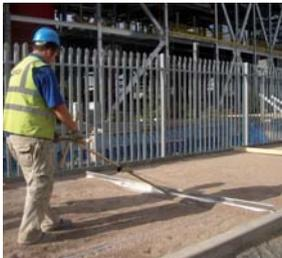
EASYPLAN EP-UNI Système de nivellement manuel
