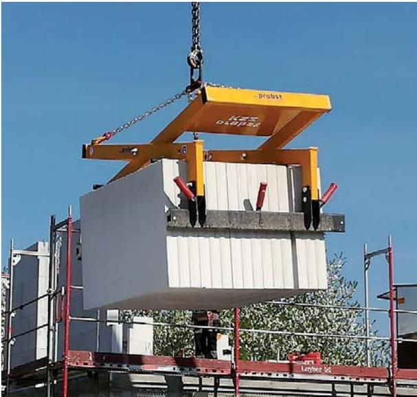
Pince pour éléments du brique silicium calcaire KSZ-300-UNI
