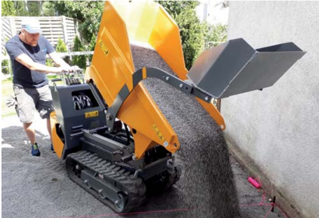
MM-KA mit Fahrgestell von MM-150-D im Einsatz
