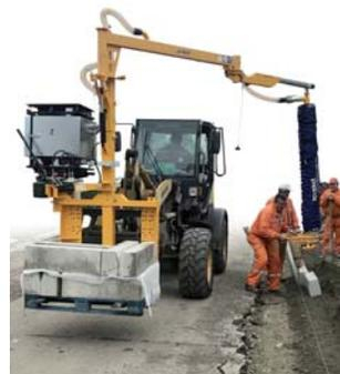
Bordsteinverlegung direkt von der Palette. Ansaugen, heben und verlegen in einem Arbeitsgang bis zu 250 kg.
