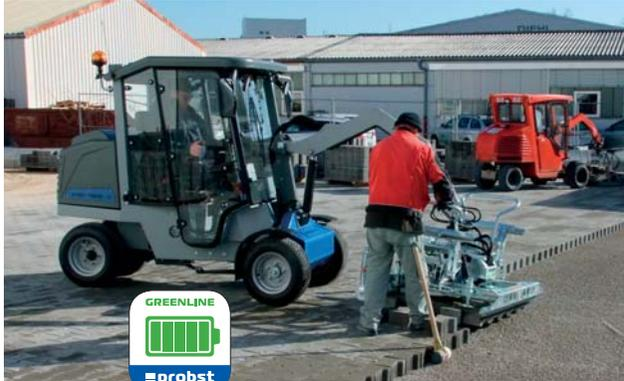
Sechs Stunden Pflaster verlegen – **laufruhig, geräuscharm und ohne Abgase**. Die weltweit erste vollelektrische Verlegemaschine ist auf Ausdauer ausgelegt. Von besonderem Vorteil auch beim Einsatz in Bereichen mit verschärften Grenzwerten für Abgas- und Schallemissionen, z.B. in Tiefgaragen oder in der Nähe von Krankenhäusern und Schulen.
