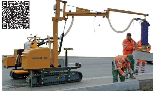
Kompakte Universalmaschine, die den Palettentransport und die Vakuum-Verlegung in einem Gerät abdeckt. Die leistungsfähige Vakuum-Verlegeeinheit erlaubt die sofortige Verlegung der schweren Bauelemente bis zu 250 kg rückenschonend und federleicht. Das Fahrwerk mit Gummiketten eignet sich besonders für unebenes Gelände.
