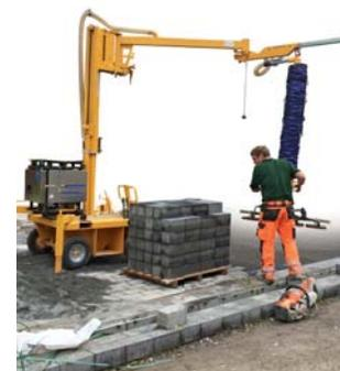
Betonplatten, Natursteinplatten und Großpflaster mühelos und exakt bis zu 200 kg verlegen.
