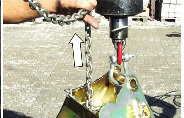
26. ... und unter der angehobenen Last durchwerfen/durchführen. **Niemals dabei unter die Last (Steinplatte) mit den Händen fassen! Quetschgefahr!**
